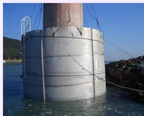
4. Нанесение покрытия
