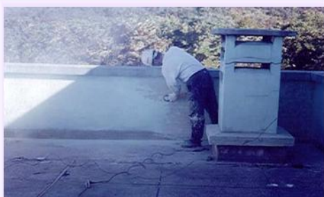
3. Нанесение керамического покрытия
