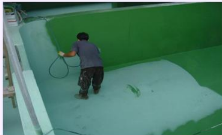
3. Нанесение керамического покрытия
