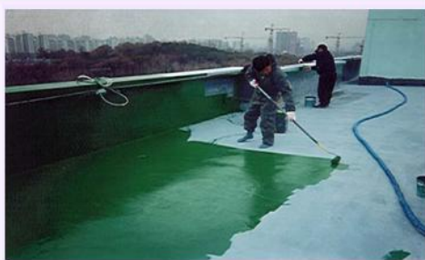
3. Нанесение керамического покрытия
