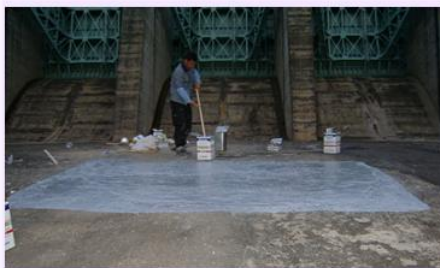
3. Нанесение керамического покрытия
