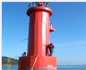
4. Нанесение покрытия
